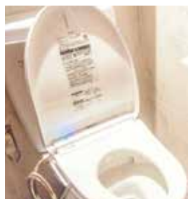
トイレの洋式化改修
