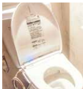
【トイレの洋式化改修】
