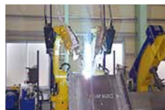
【建築用鉄骨構造体の自動溶接に自動ロボット導入、今後のインフラ需要対応】
