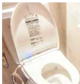
【トイレの洋式化改修】
