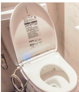
トイレの洋式化改修
