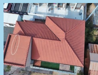
状態検査で撮影した写真
