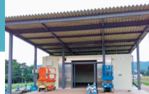
導入した冷蔵庫
