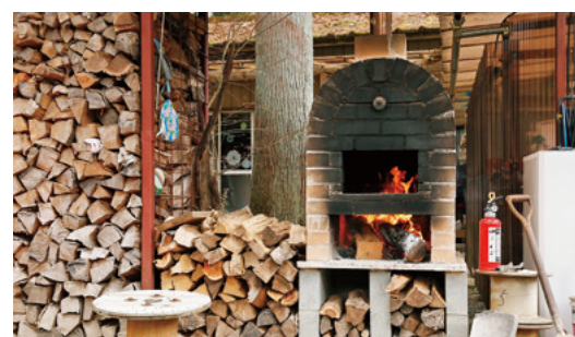
煉瓦造りのピザ窯を設置
